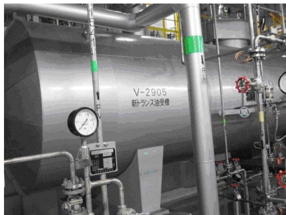
【腐食対策で転用した貯蔵タンク】
