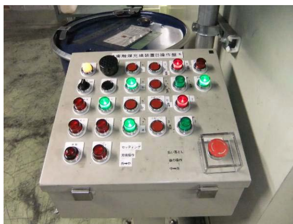
(2) 東棟 1 階生成物回収室操作パネル
