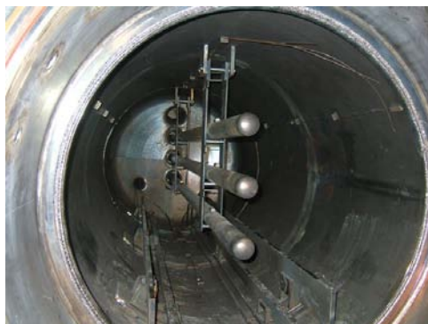
改善前（ヒーター有り）
