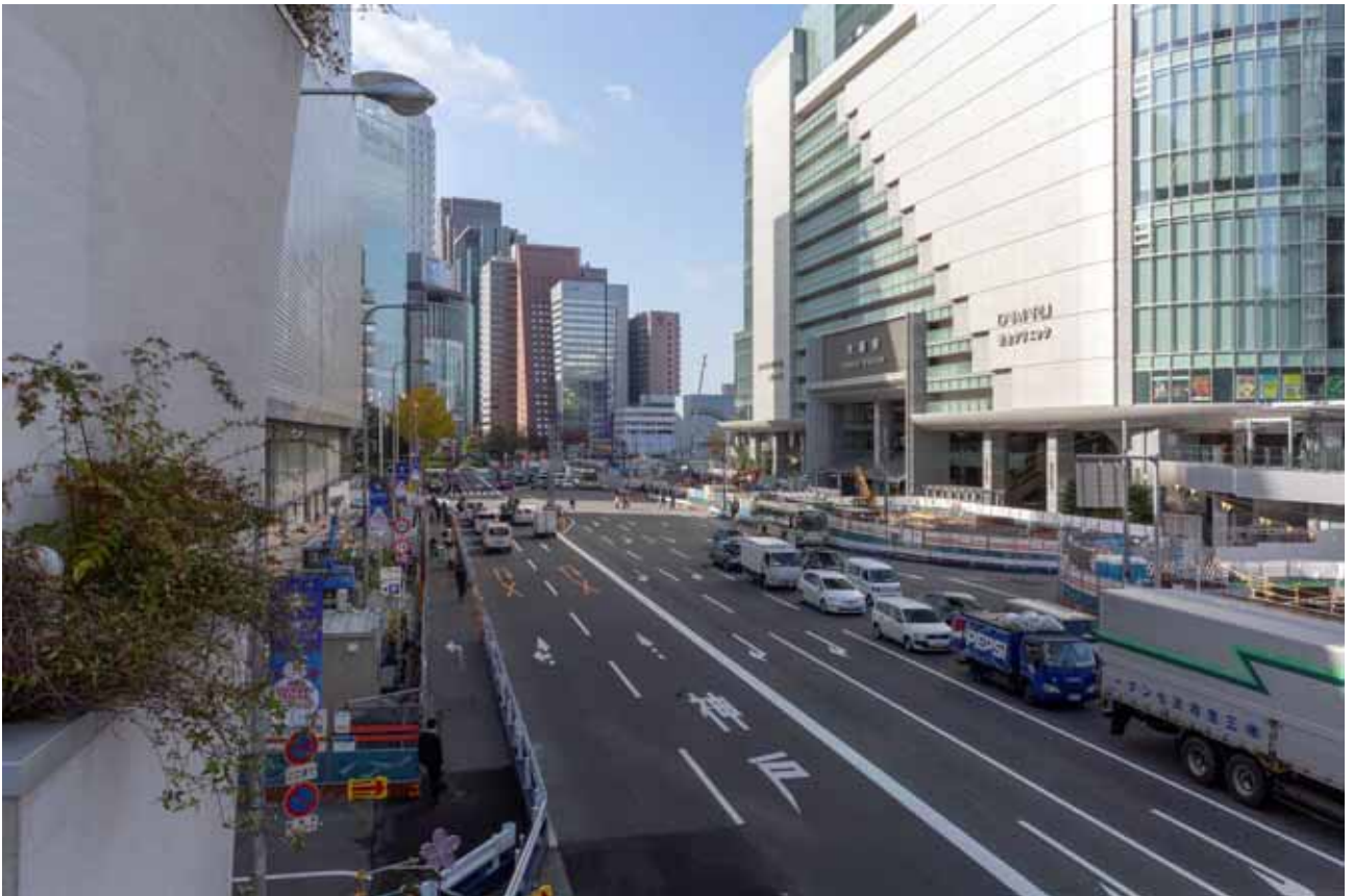
図 5-12-2(1) 梅田新歩道橋上からの景観（現況）
