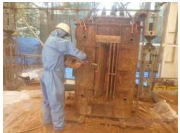
大型トランスのフィン外し
