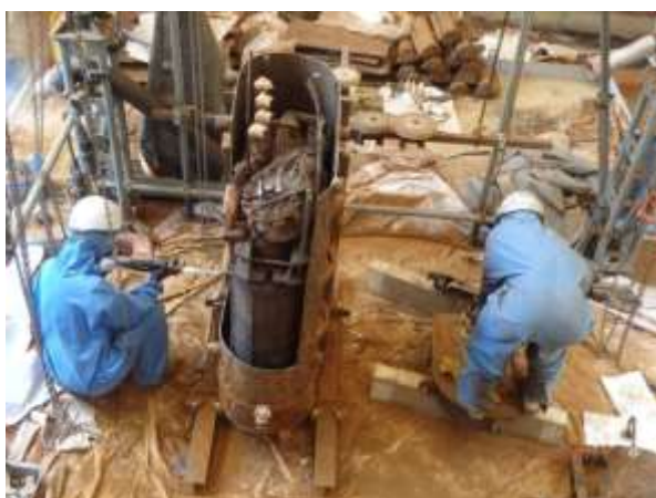
コアの抜き出しのための切断
