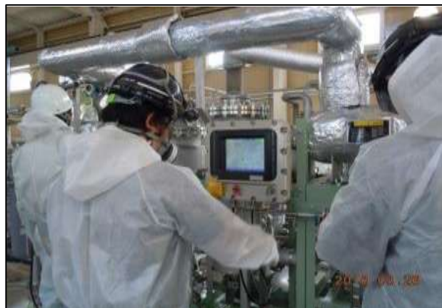
抜油作業のメーター類チェック
