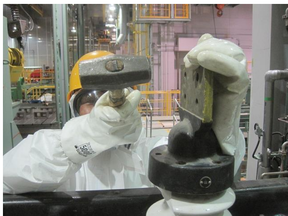
大型トランス解体作業（ブッシング取り外し）
