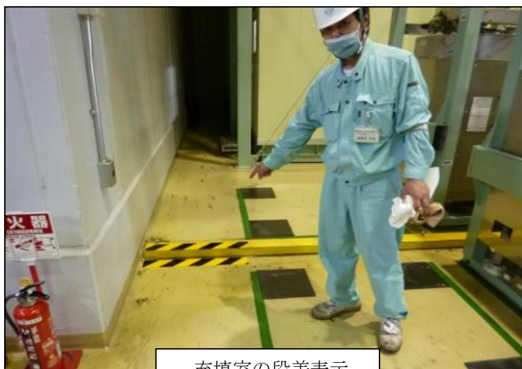
充填室の段差表示
