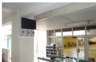
鯉江小学校（城東区） 体育館入口に設置
