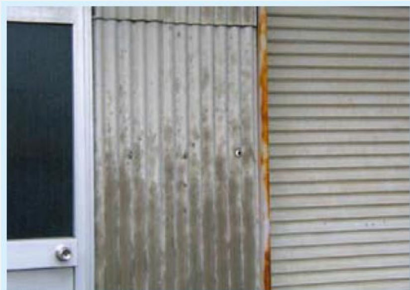
石綿スレート（屋根・外壁）
