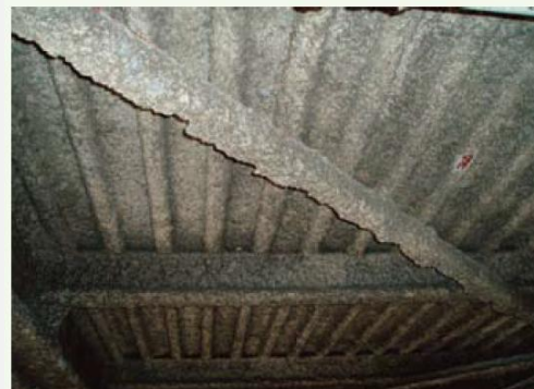
断熱用吹付け石綿・石綿含有吹付けロックウール（折版屋根裏、デッキプレート床裏、階段裏・庇裏等）
