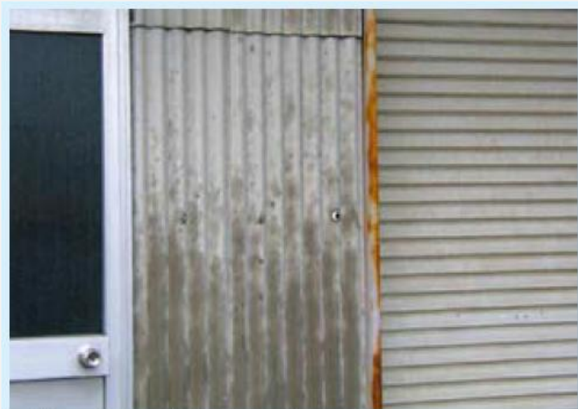
石綿スレート（屋根・外壁）
