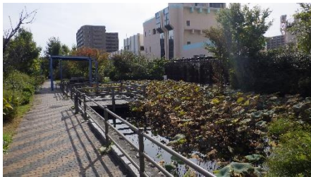
放出下水処理場上部利用施設
