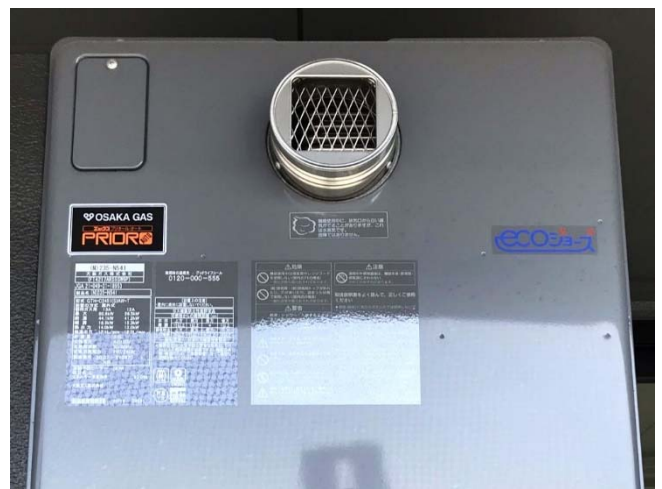
写真 18：高効率給湯器（住宅専有部）
