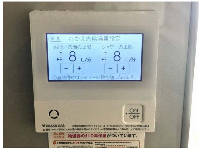
写真 8 : エコ運転機能付き給湯リモコン (住宅専有部)
