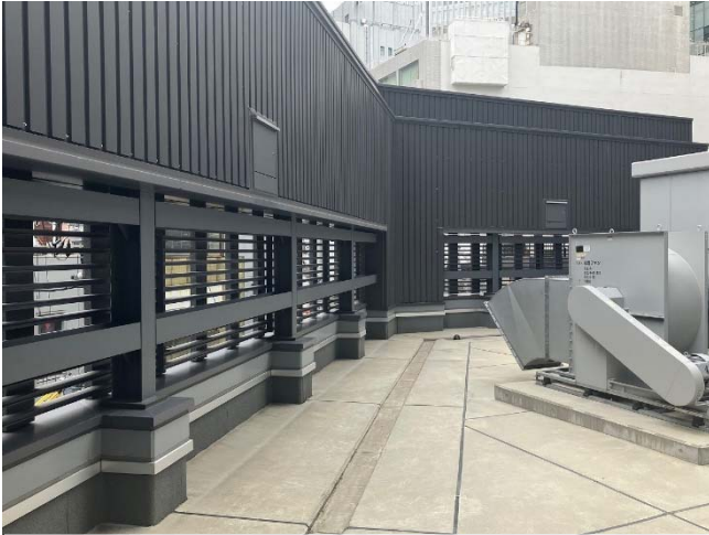
写真1：熱源機器周囲壁
