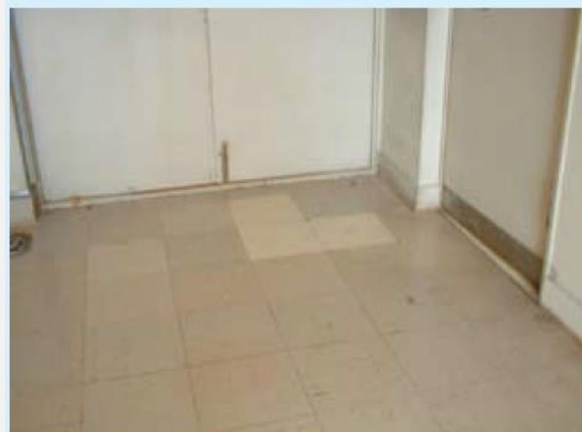
石綿含有ビニール床タイル（床）
