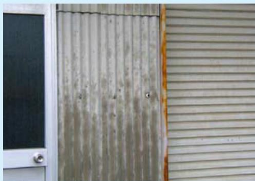
石綿スレート（屋根・外壁）
