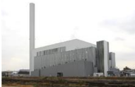
大阪広域環境施設組合 東淀工場
