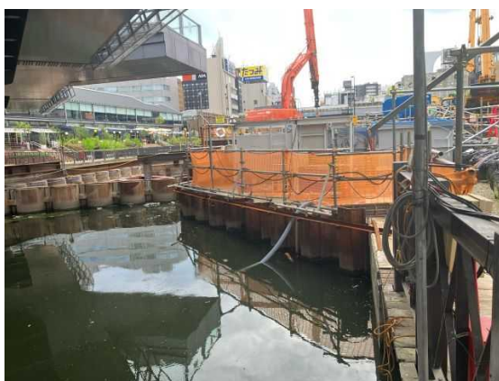
写真 8.15 仮締切時の工事排水口の状況
