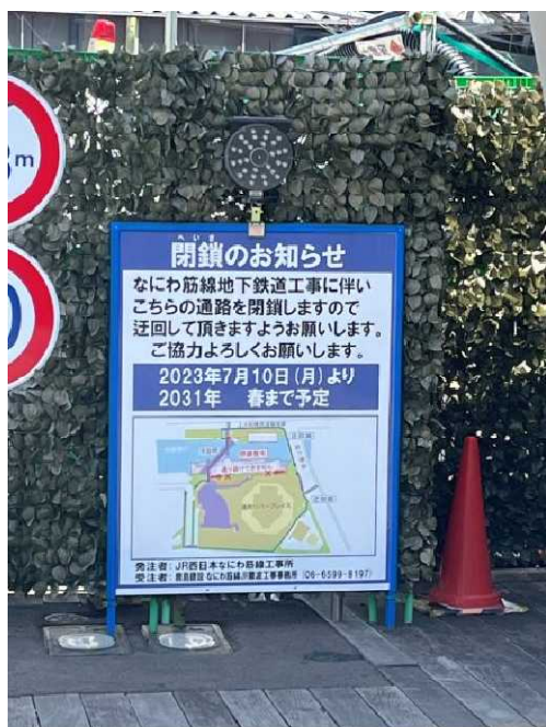
写真 8.17 工事内容の掲示状況
