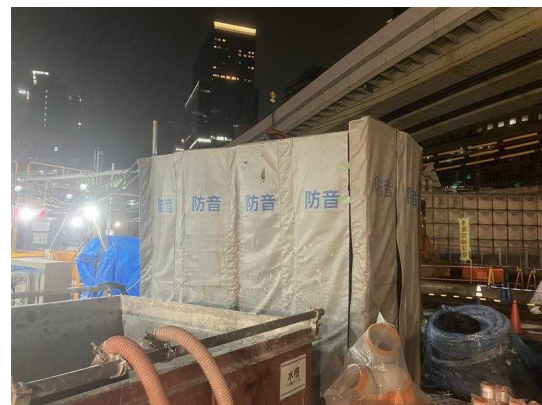
写真 8.8 防音シート設置状況（夜間）
