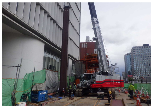
写真 8.12 土留工 (CRM 工法) 施工状況
