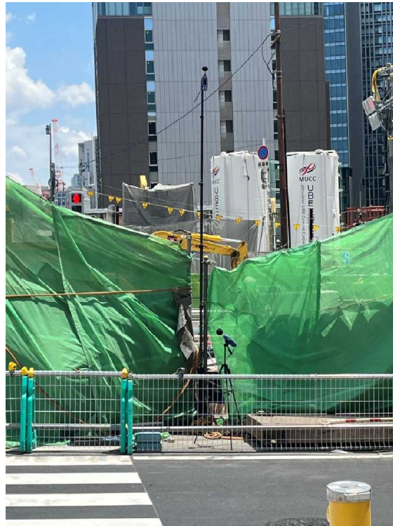
写真 8.20 騒音・振動事後調査実施状況 (中之島駅区間)
