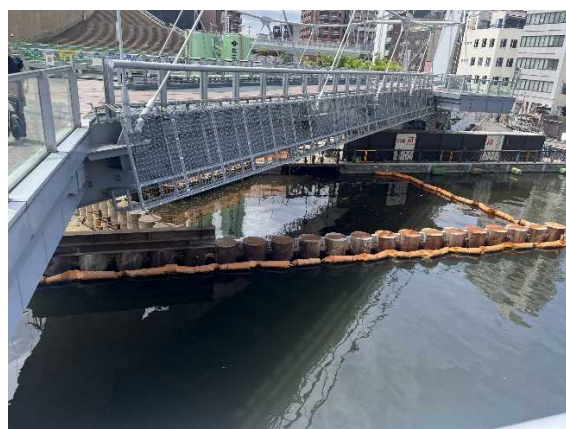
写真 8.13 汚濁防止膜設置状況
