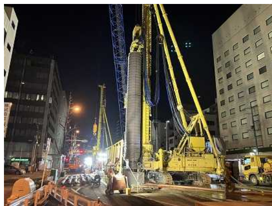
写真 8.10 土留工 (ECOMW 工法) 施工状況
