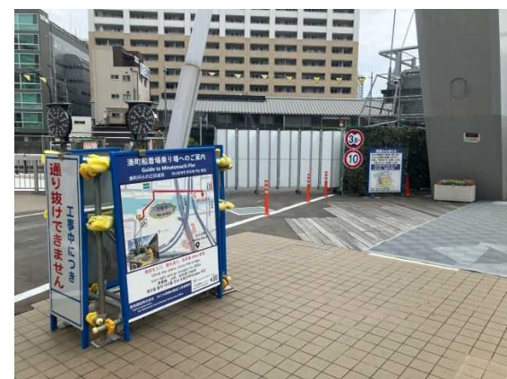
写真 8.16 万能塀の景観配慮状況
