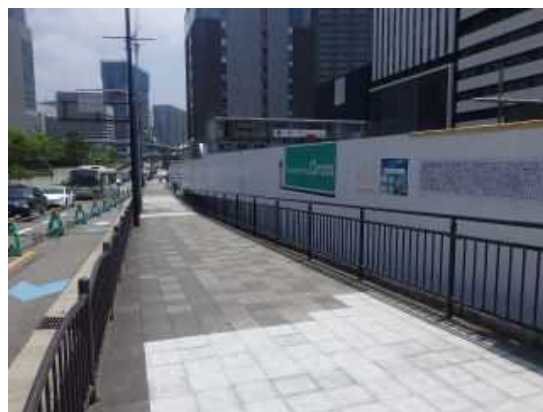
写真 8.4 万能塀設置状況
