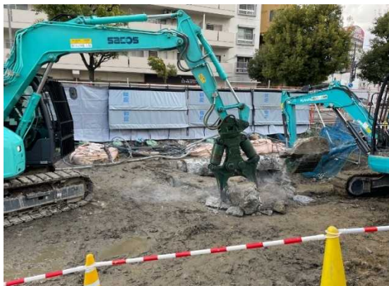
写真 8.7 防音シート設置状況
