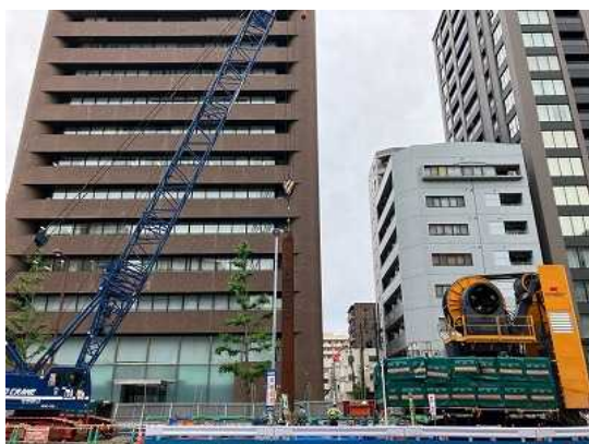
写真 8.11 土留工 (CSM 工法) 施工状況
