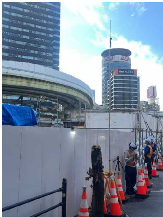
写真 8.19 騒音・振動事後調査実施状況 (北梅田立坑区間)
