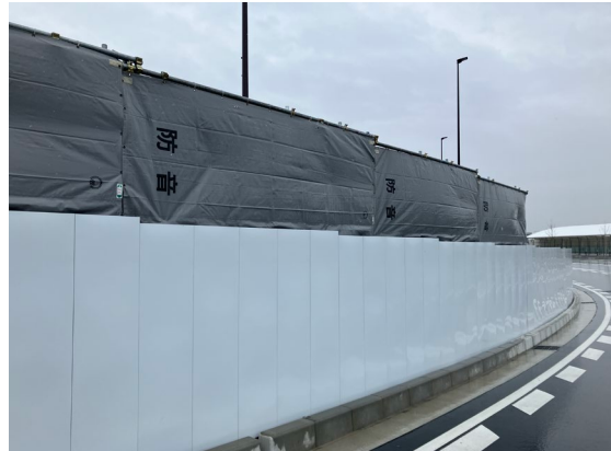
写真6 仮囲い・防音シートの設置
