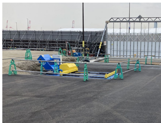
写真4 タイヤ洗浄装置
