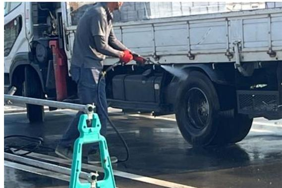
写真6 飛散防止等のタイヤ洗浄
