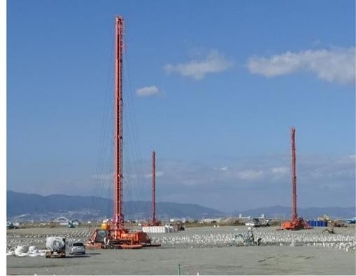
写真8 回転圧入式杭工法
