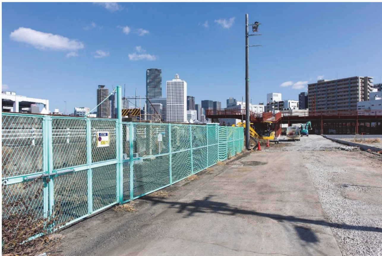
図 5-9-7(1) 大阪開港の地からの景観（現況）
