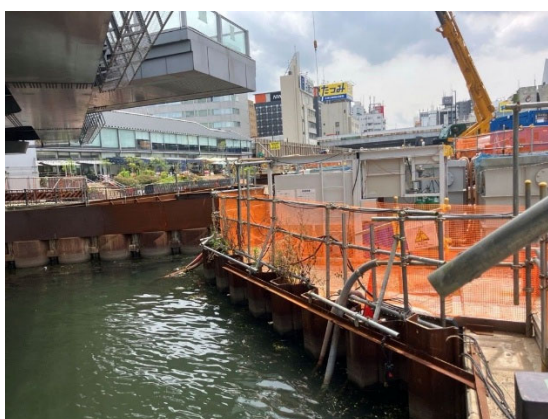
写真 8. 15 仮締切時の工事排水口の状況
