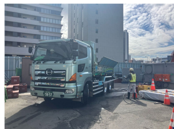
写真 8.8 タイヤ洗浄状況
