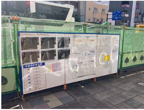
写真 8.17 工事内容の掲示状況
