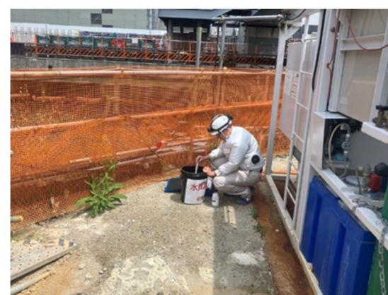
写真 8. 14 水質施工管理の状況
