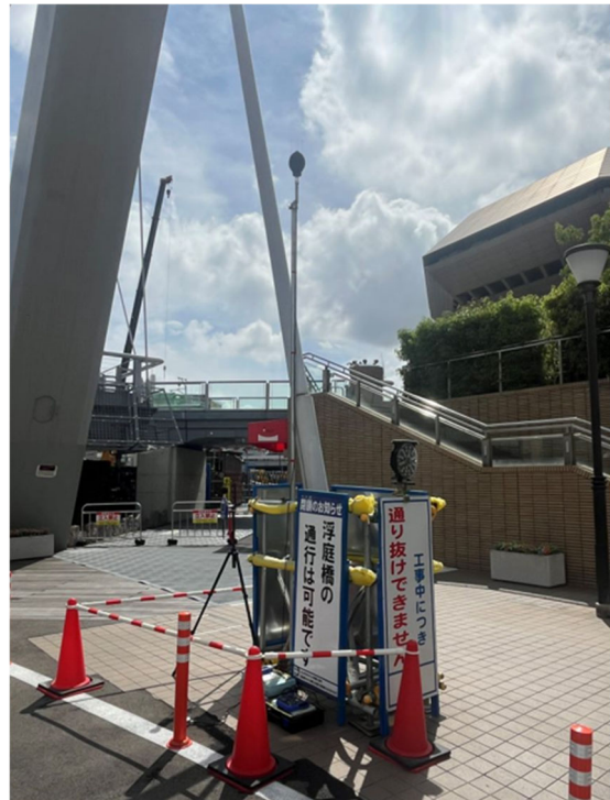
写真 8.20 騒音・振動事後調査実施状況 (JR 難波駅取付部区間)
