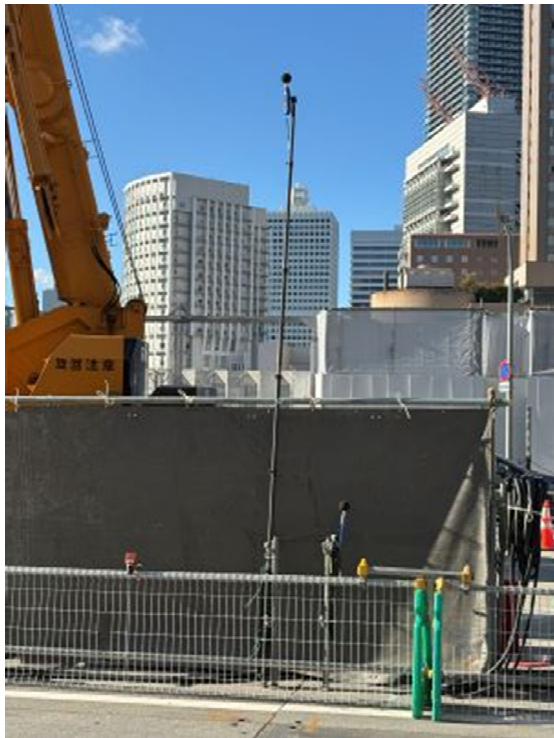
写真 8.19 騒音・振動事後調査実施状況 (中之島駅区間)
