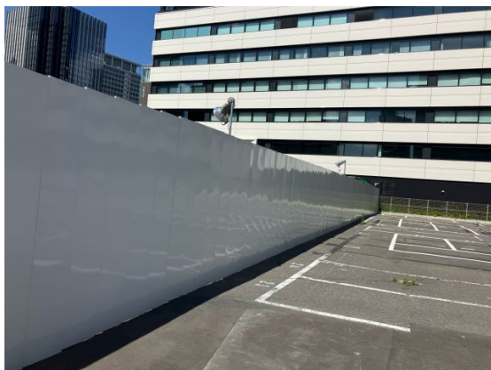
写真 8.5 万能塀設置状況
