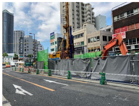
写真 8. 10 防音シート設置状況
