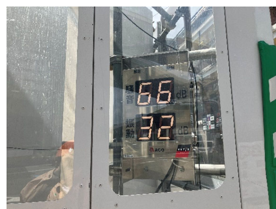
写真 8. 12 騒音・振動の計測・表示
