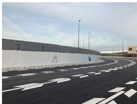
写真6 仮囲い・防音シートの設置
