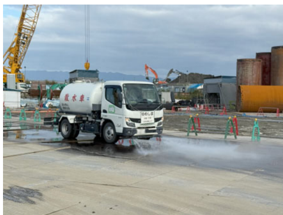
写真5 散水の実施の様子
