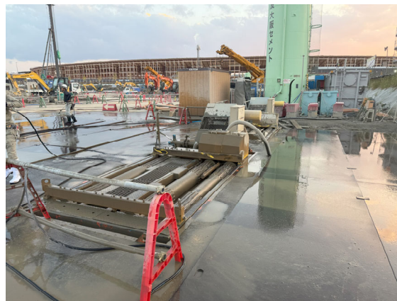
写真4 タイヤ洗浄装置
