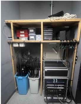
・音響倉庫増設、整理
