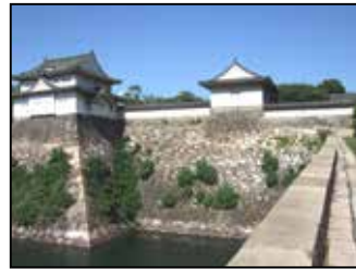
大手土橋北側の石垣、建物は千貫櫓 (第 1 期)
