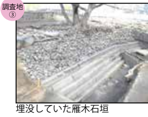
埋没していた雁木石垣
