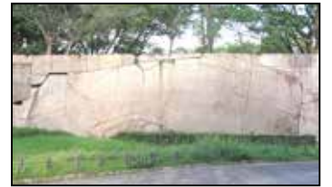
肥後石 (京橋門枳形)
