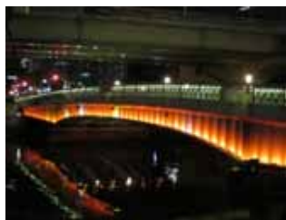
鉾流橋ライトアップ
