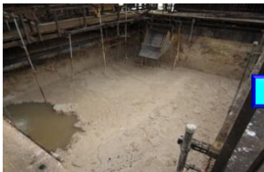
浮上滞留する油脂分の悪臭と回収に手を焼いていた排水処理槽が...
