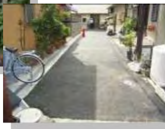
狭あい道路 整備後
