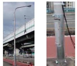
中島新橋・木津川大橋上の実照明柱、実証計測、振動低減効果確認(H26)
