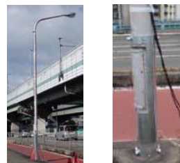
中島新橋・木津川大橋上の実照照明柱、実証計測、振動低減効果確認(H26)
