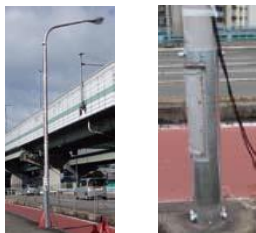
中島新橋・木津川大橋上の実照明柱、実証計測、振動低減効果確認 (H26)
