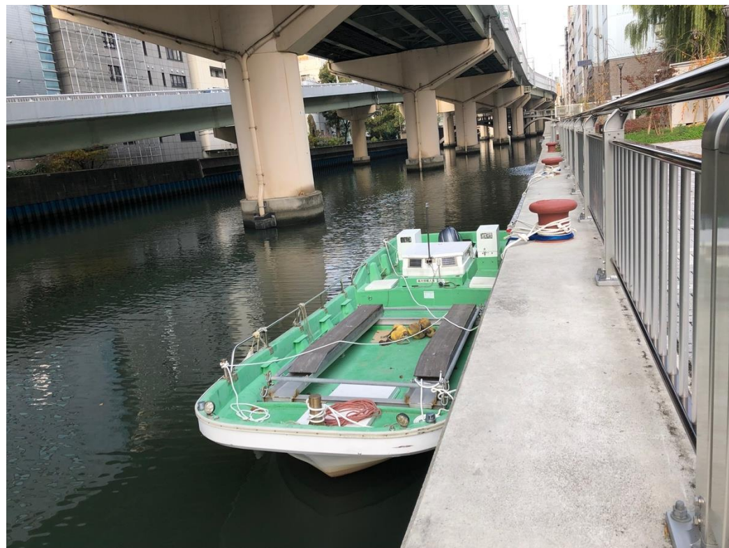
保管係留している船舶（施設北側公園の護岸）
