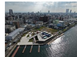
中之島GATEサウスピア
