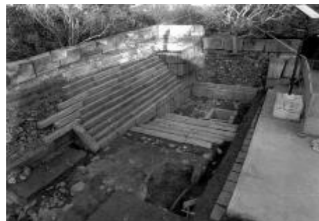
図 41 埋没している徳川期の遺構 (雁木 4 段目以下が埋没)
