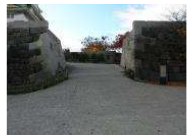
図 97 車両用に舗装された通路
