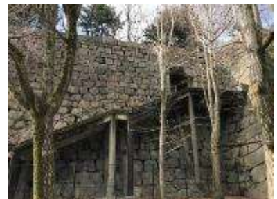
図 96 昭和6年に整備された、石垣を貫通する通路
