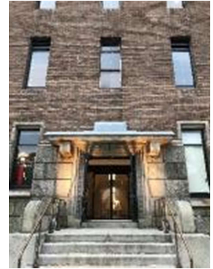
図90 保存された 創建時の窓 （出入口真上）
