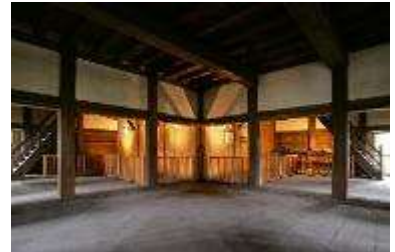
図 127 乾櫓内部（重要文化財）
