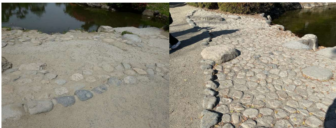
ごろた石が外れて歩きやすくなった石畳を改修
