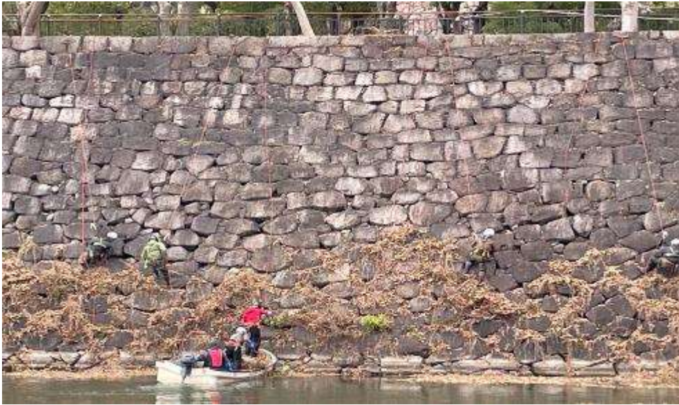
石垣清掃作業状況
