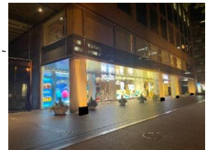
銀泉備後町ビル
