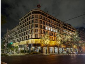
大阪ガスビルディング
