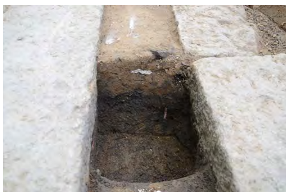
北辺排水溝断面（東から）
