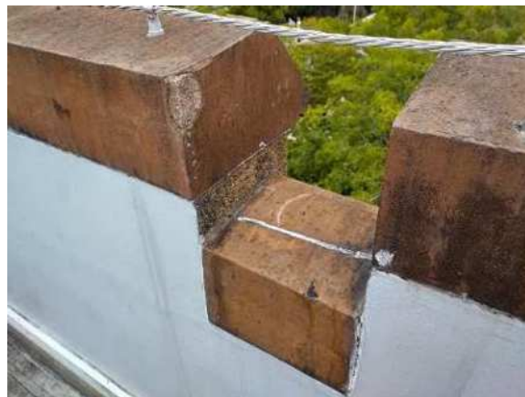
笠木補修状況（東面）
