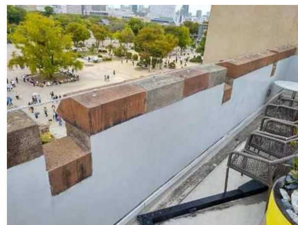
笠木補修状況（西面）
