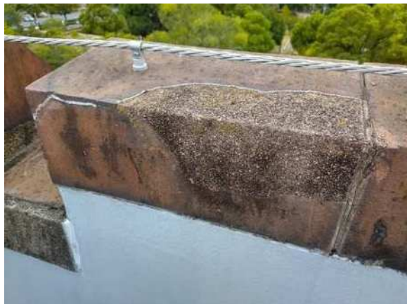
笠木補修状況（西面）
