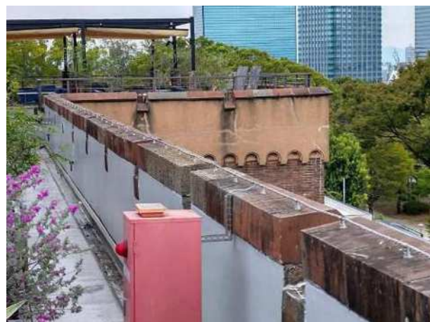
笠木補修状況（南東面）
