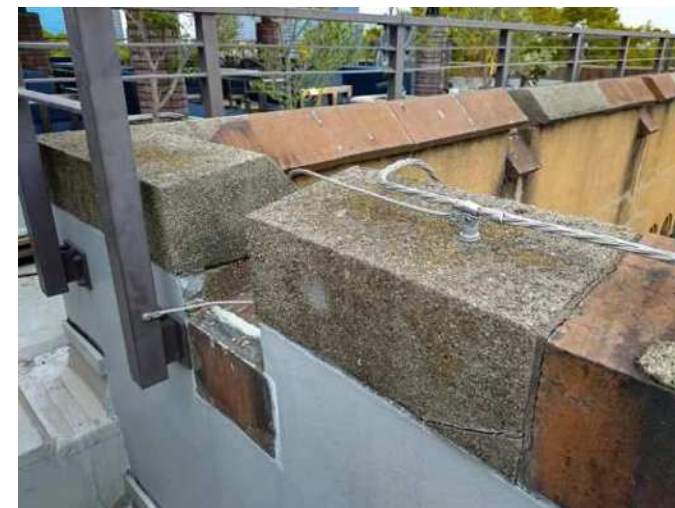
既設笠木の現状（モルタル補修）
