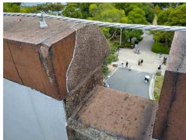
笠木補修状況（西面）
