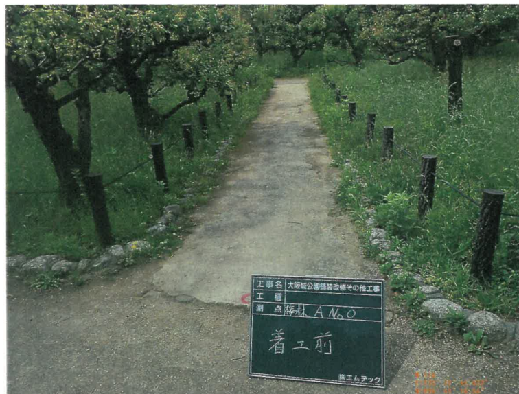
路線 A No.0 着工前
