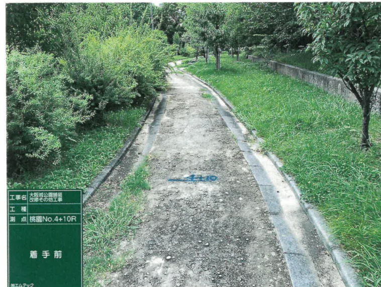
桃園 着工前 NO.4+10.0 R側
