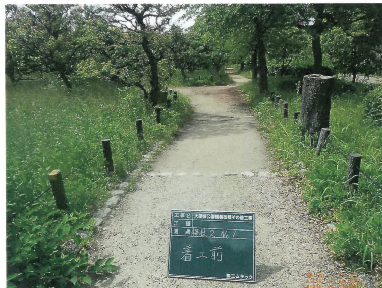
路線 2 No.1 着工前
