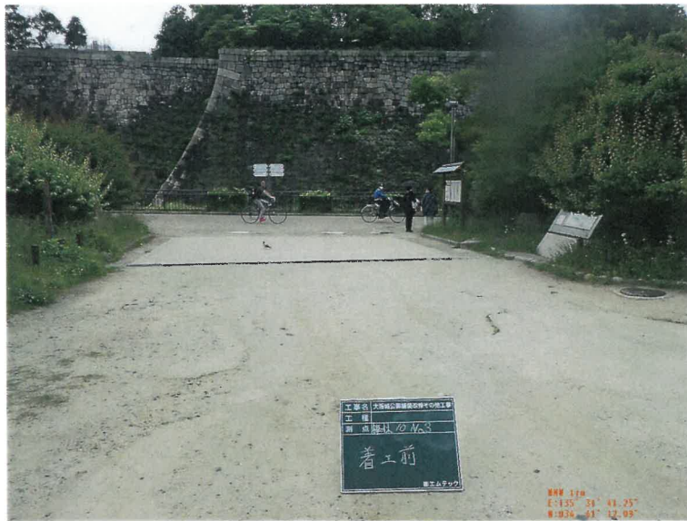
路線 10 No.3 着工前
