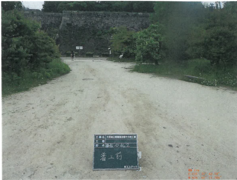
路線 10 No.2 着工前
