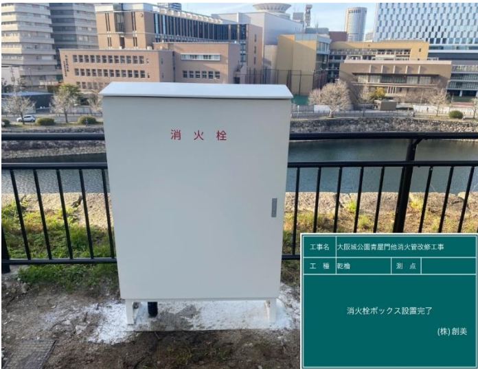
乾櫓（北側）完了
