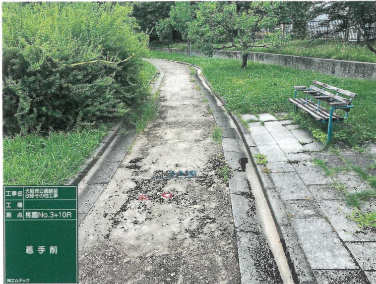
桃園 着工前 NO.3+10.0 R側
