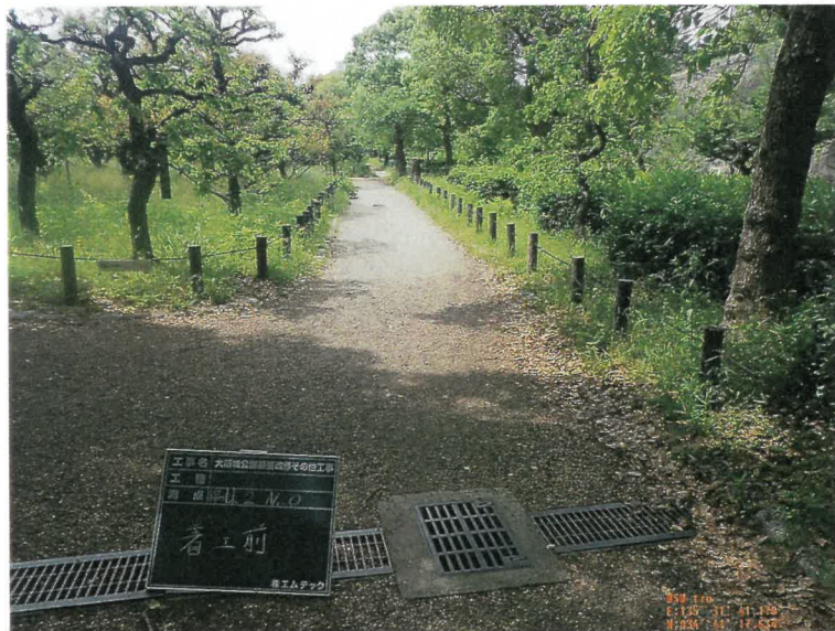
路線 2 No.0 着工前
