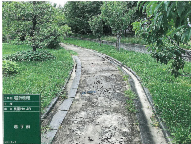
桃園 着工前 NO.4 R側
