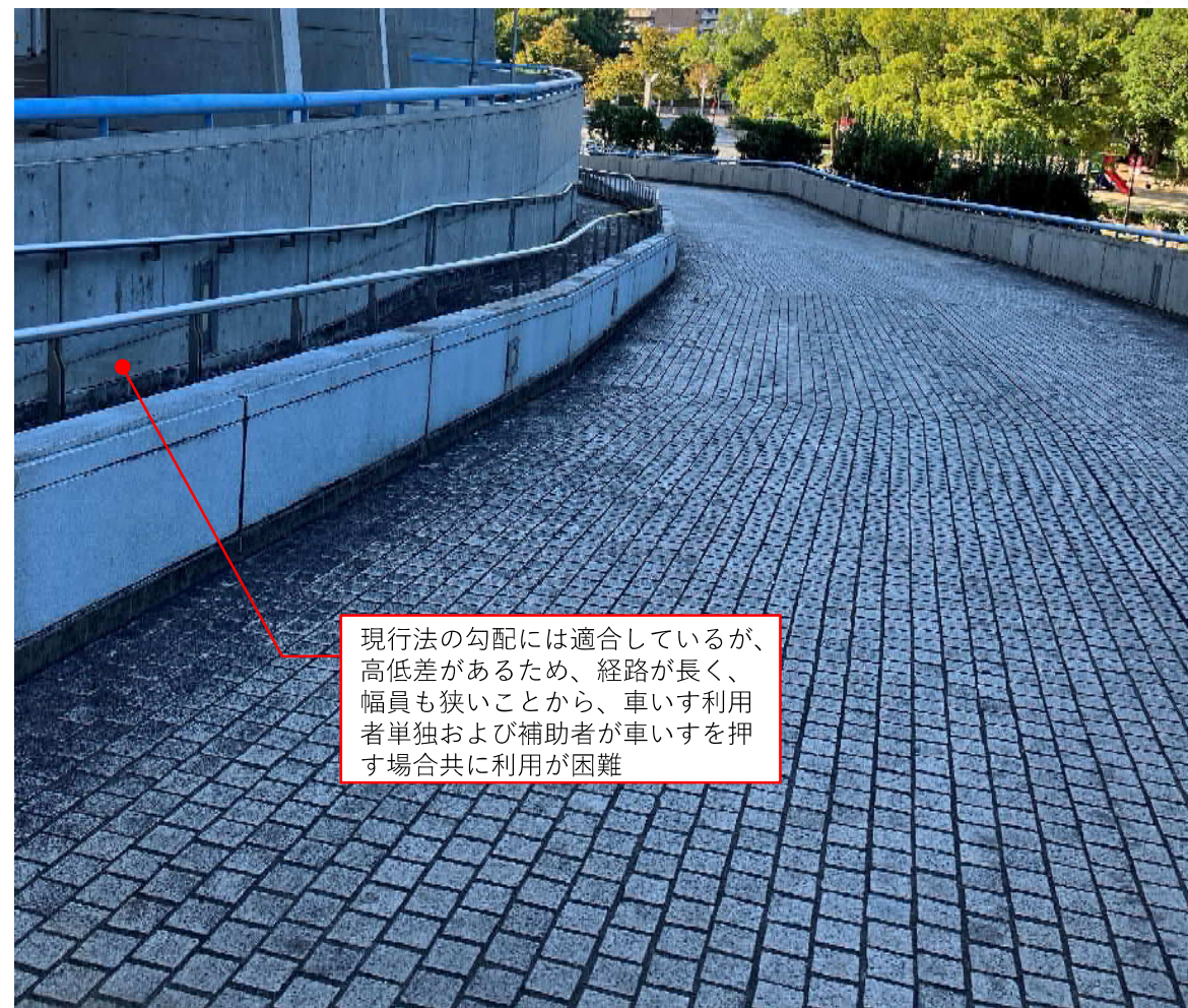
【現況写真 スロープ上部から下部を撮影】
