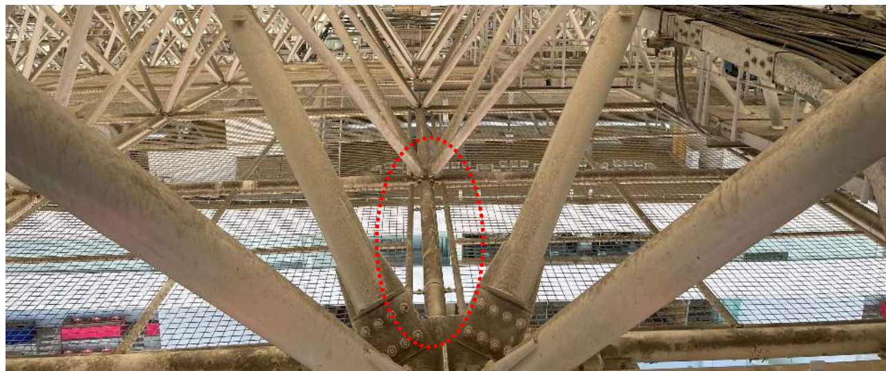
【現況写真3 大屋根内部から下部防鳥ネットを撮影】
