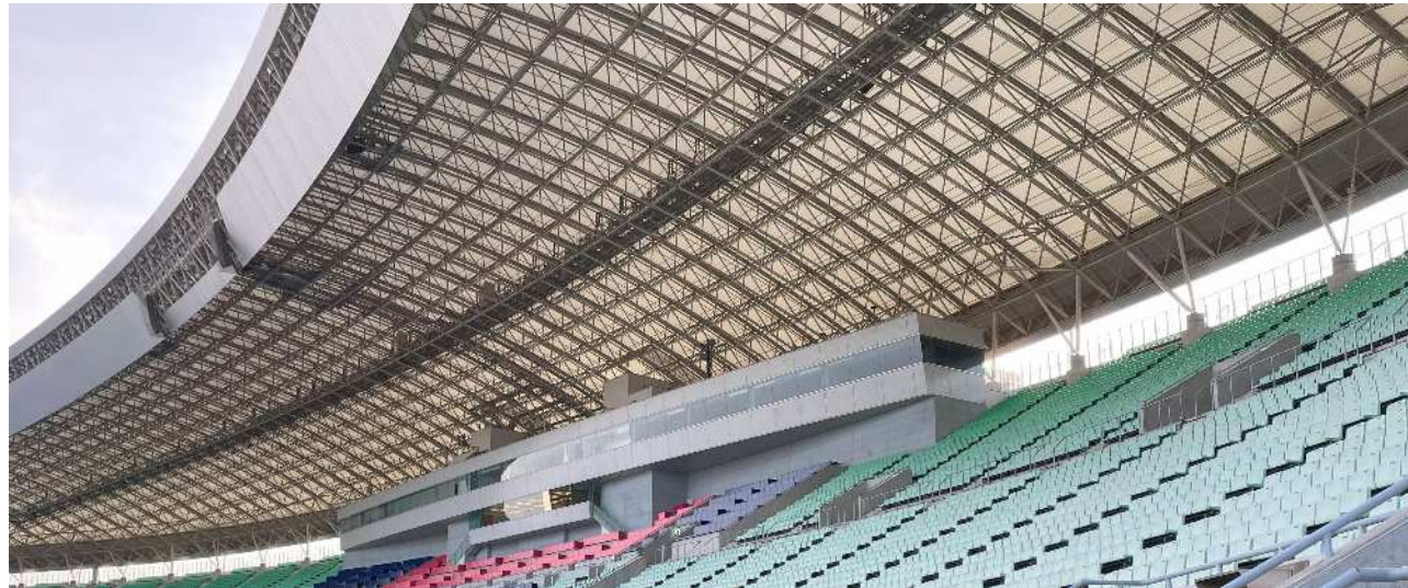
【現況写真1 スタンドより上部防鳥ネットを撮影】
