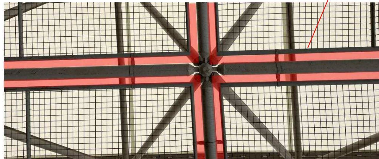
【現況写真2 スタンドより上部防鳥ネットを撮影】
