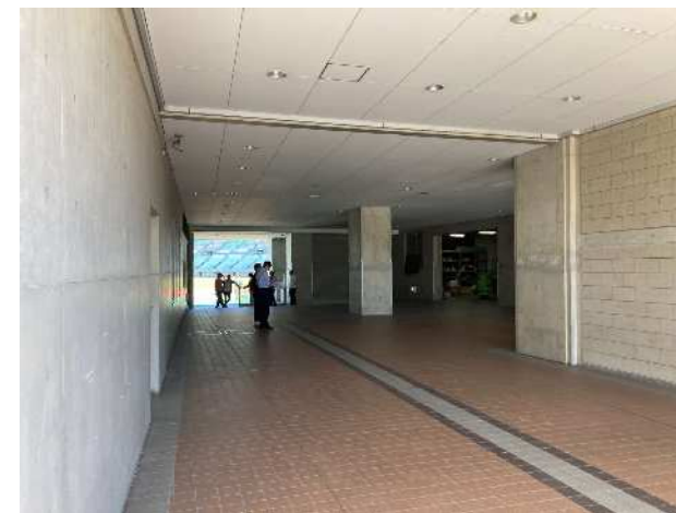
【現況写真 ゲート1】
