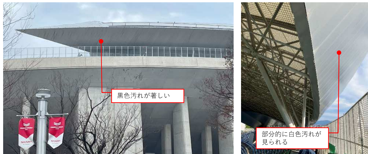
【現況写真 左：バックスタンド屋根南側 右：メインスタンド最上部より軒先パネルを撮影】
