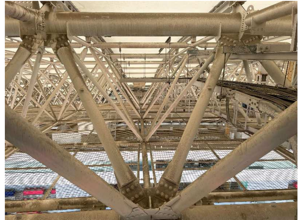
【現況写真 屋根内からトラス鉄骨を撮影】
