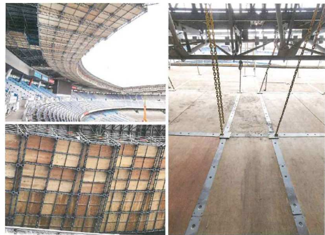
【参考写真 吊り足場設置事例】
