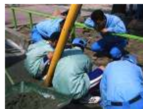
初体験のモルタル補修に慎重な面持ちの生徒たち
