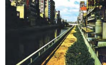
■グリーンベルト(舟型護岸)の完成 昭和42年頃
