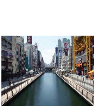
■整備後の道頓堀川 (道頓堀川戎橋～太左衛門橋区間)
