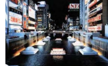
■ウォーターカーテンの設置 平成元年
