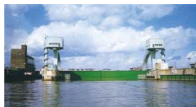
●閉鎖完了(木津川水門)
