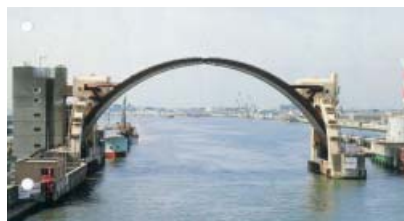
●全開状態(安治川水門)
