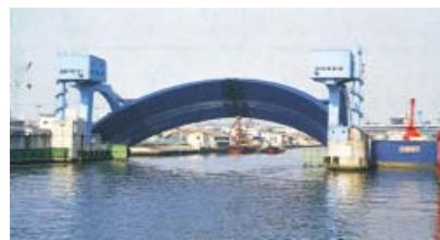
●閉鎖中(尻無川水門)
