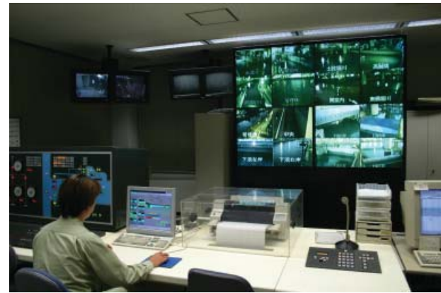
道頓堀川水門操作室
