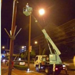
高所作業車による点検状況
