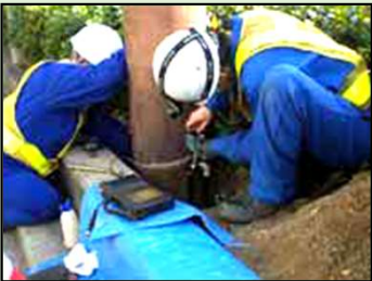
支柱鋼材の肉厚調査の状況
