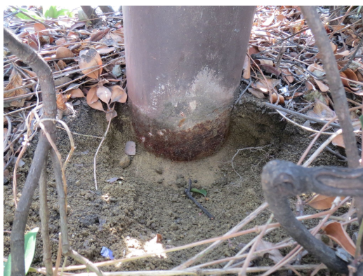
参考写真4-1 地際部における損傷や過度の振動による損傷事例
