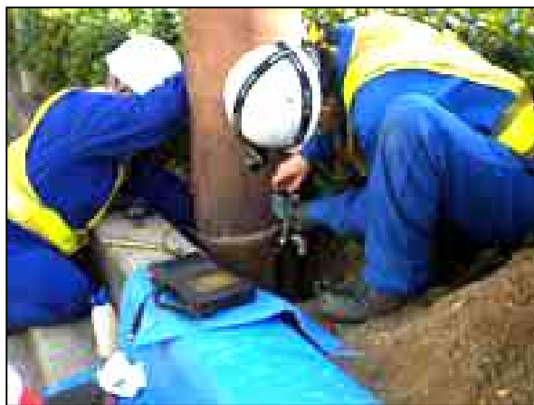
支柱鋼材の肉厚調査の状況
