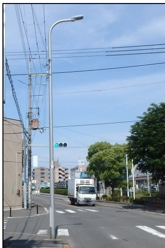
参考写真1－1 柱上灯（左）と共架灯（右）
