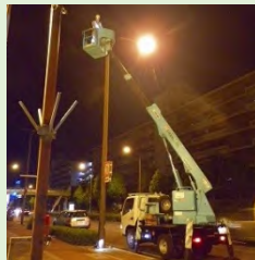
高所作業車による点検状況
