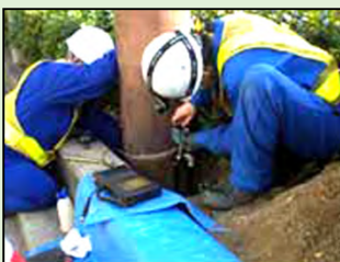
支柱鋼材の肉厚調査の状況
