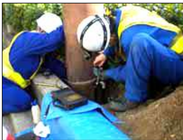
支柱鋼材の肉厚調査の状況
