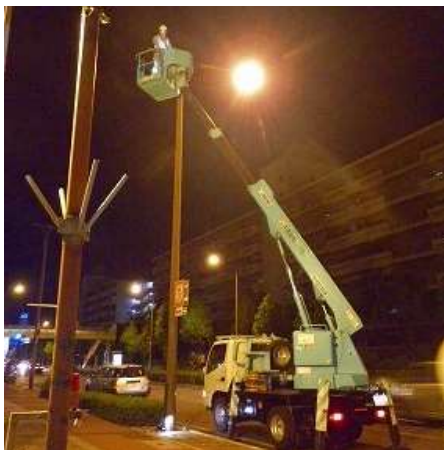
高所作業車による近接目視点検状況
