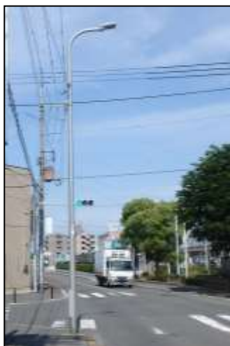
参考写真1-1 柱上灯（左）と共架灯（右）
